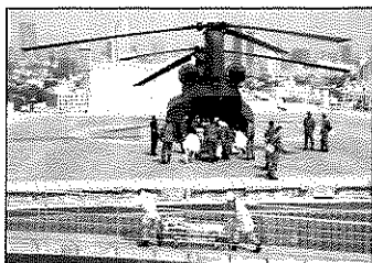
屋上ヘリポート
